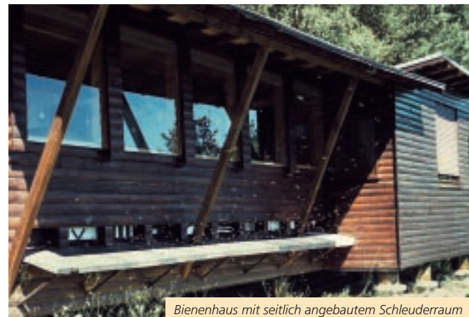
Bienenhaus mit seitlich angebautem Schleuderraum
