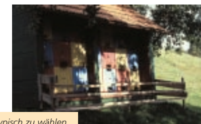
Die Dachform und -eindeckung ist landschaftstypisch zu wählen. Ein Satteldach mit 20 - 30° Neigung passt sich erheblich besser in die Landschaft ein als ein Pultdach. Zudem kann dadurch zusätzlicher Stauraum geschaffen werden.
