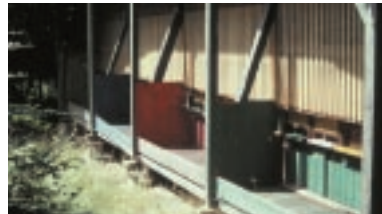
Nur einfach gebaute Bienenhäuser mit möglichst leicht zerlegbarer Holzkonstruktion auf nicht massiven Fundamenten sind zulässig. Zur Belichtung erhielt die Vorderseite Lichtwellplatten.
