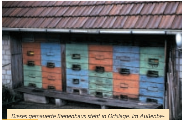
Dieses gemauerte Bienenhaus steht in Ortslage. Im Außenbereich ist es nicht zulässig, da es einen sehr starken Eingriff in das Landschaftsbild bewirkt. Es ist zudem kleinklimatisch - bedingt durch die schlechte Erwärmung und lange Speicherung der Kälte im Frühjahr - der Bienenentwicklung abträglich.
