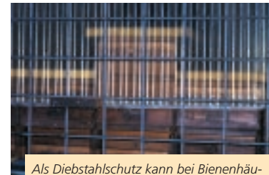
Als Diebstahlschutz kann bei Bienenhäusern ein Gitter vor die Lichtflächen angebracht werden.
